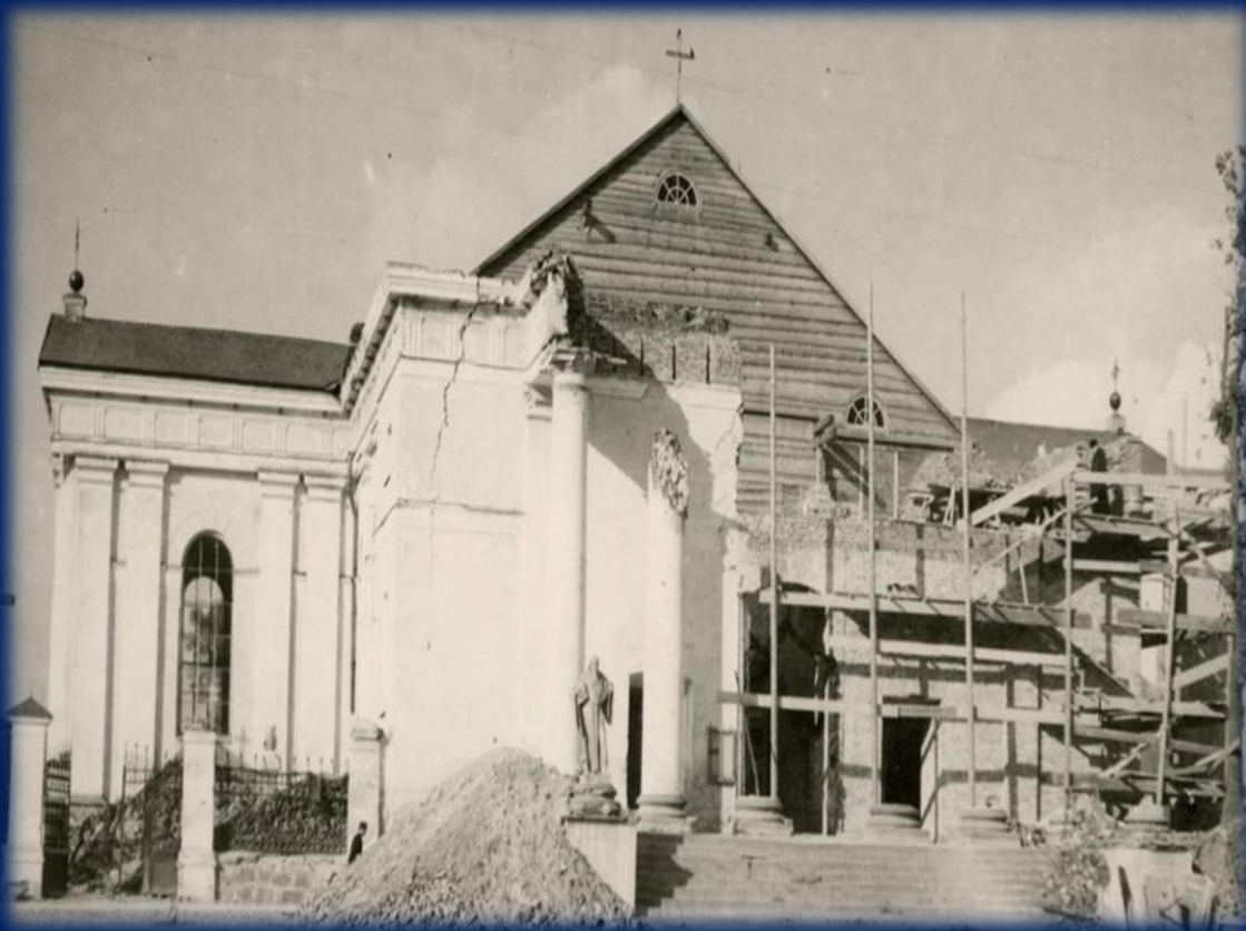
Kościół św. Aleksandra – po wysadzeniu wież w październiku 1944 r.
